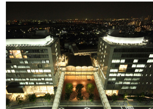
2、3号館俯瞰 / 屋上からの投光照明で照らされたキャンパスプラザ。
