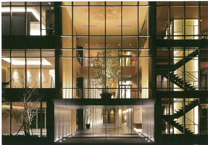
図1 ファサードの照明 Fig.1 Illuminations of façade.
