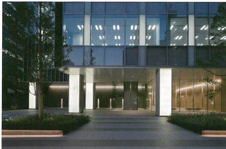
図1 エントランス Fig.1 Entrance.
