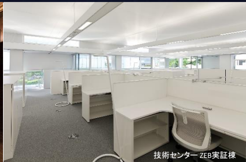
技術センター ZEB実証棟
