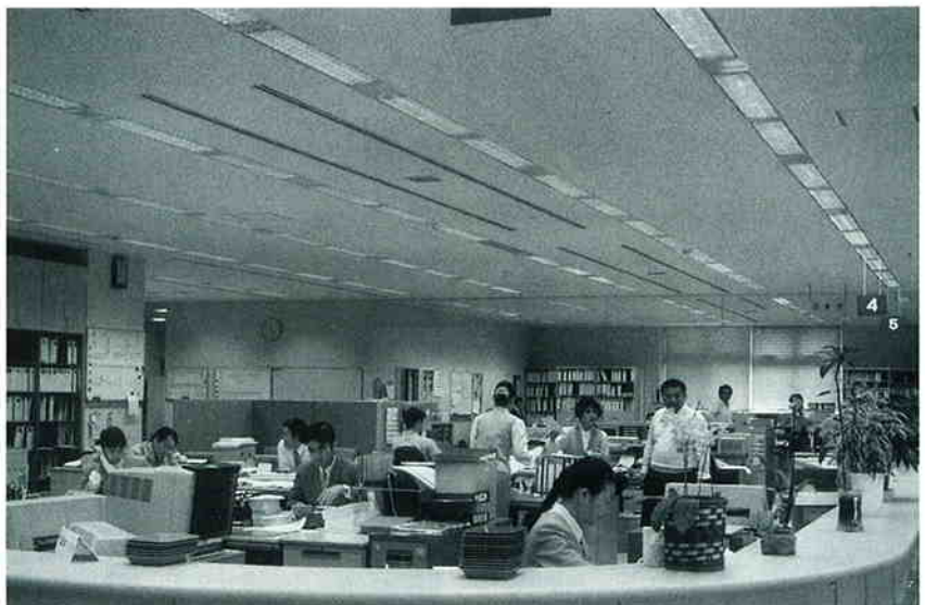
▲沖縄電力株浦添営業所を含む地下1階地上7F建の事務所ビル。営業所のベース照明にHf32W×2灯用OALルーバ付器具を用いてグレアのない快適な執務空間をつくり出している。
