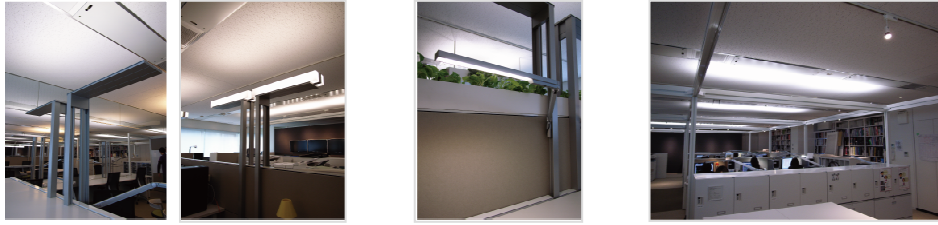
アンビエントライト タスクライト フレームアンビエントライト
