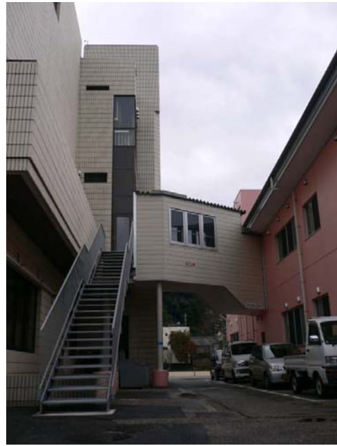
H-7 津波避難階段及び渡り廊下 (左：町役場 右：幼稚園)
