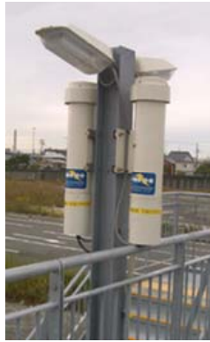
図 4.1.35 津波緊急避難施設と UPS 付照明灯
