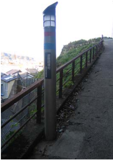
図 4.1.4 ソーラー式照明灯
