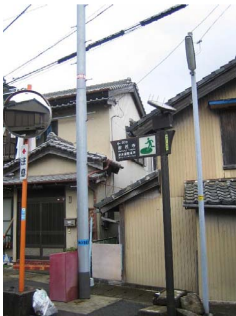
F-1 避難誘導灯
