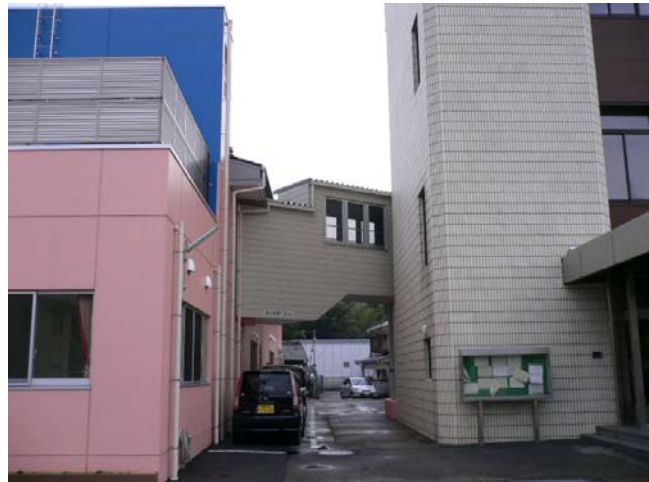
H-8 津波避難渡り廊下 (左：幼稚園 右：町役場)
