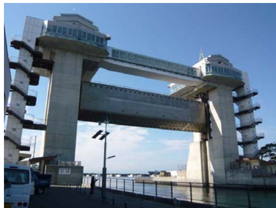
まもるタワー（水門）
