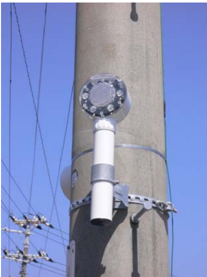
御坊市 道路分岐点の誘導灯（LED） 同左 夜間点灯時
