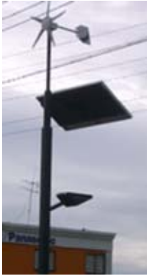
図 4.1.34 風力ソーラー併用照明灯
