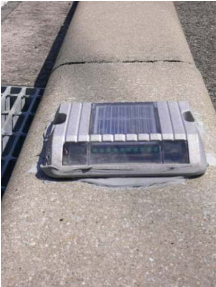
御坊市 道路縁石のエッジポインター 同左 夜間点灯時の様子（緑光） （ソーラー電源 LED）
