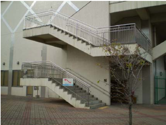
津波避難ビルの津波避難誘導板
