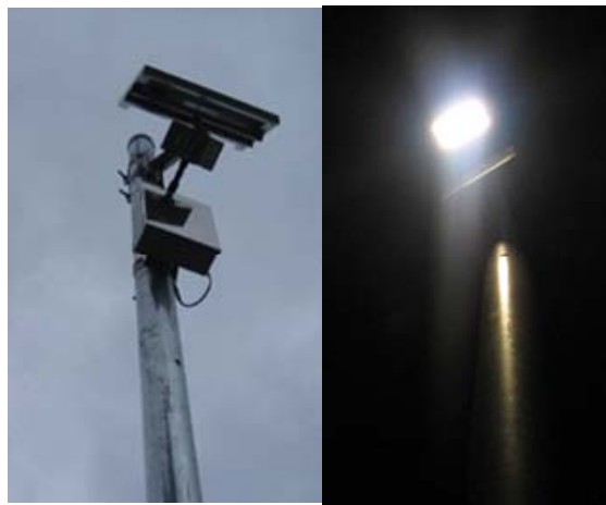
図4.1.9 ソーラー式照明灯
