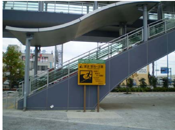
清水駅の津波避難誘導板
