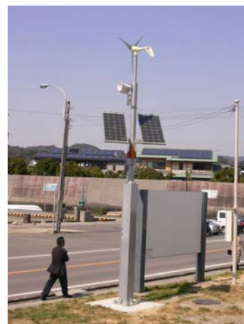
広川町 いなむらの火誘導灯 （ソーラー・風車ハイブリッド）
