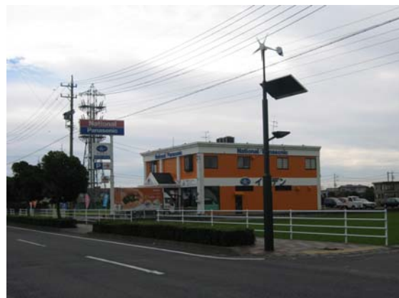
太陽灯用歩道用照明（大井川町）
