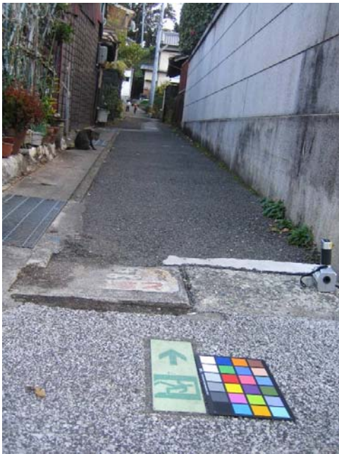
C-1 蓄光型誘導標識
