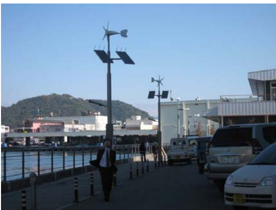
まもるタワー周囲の太陽灯用照明
