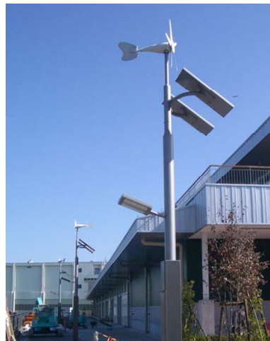
図 4. 1. 32 風力ソーラー併用照明灯
