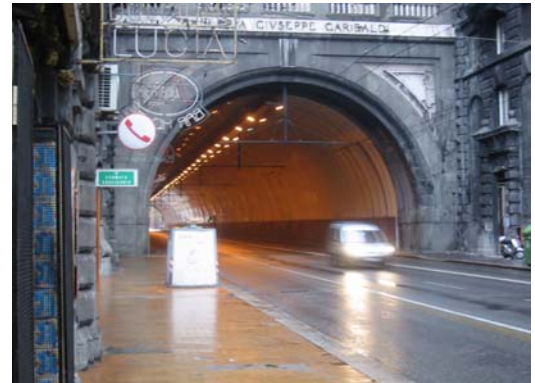
図 6.1.1 トンネル照明の一例
