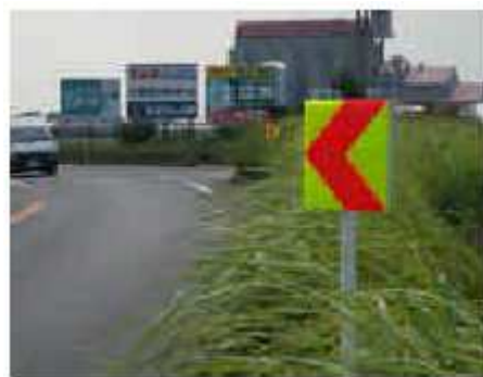
図 6.3.1-3 蛍光プリズム反射体
