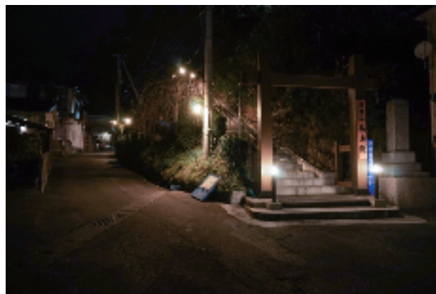
計画上は段差部を認識させるための照明は結果、鳥居をライトアップしている。階段部、横坂道の防犯灯はレトロ調の器具を採用。停電時にはキャパシタバッテリー(高寿命)を内蔵する、点滅するLED照明を併設している。
