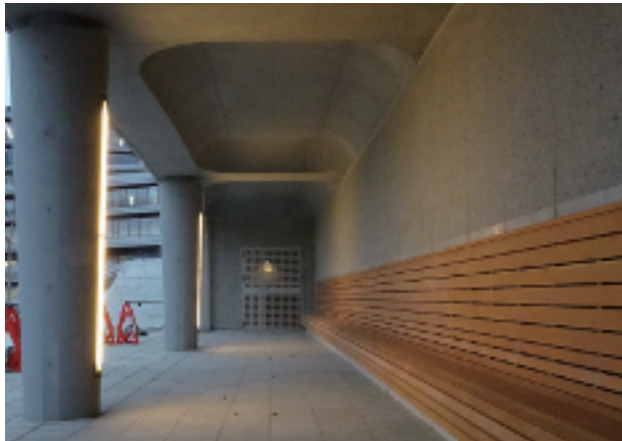
図4 構築物などに組み込まれたベンチ照明と柱照明
