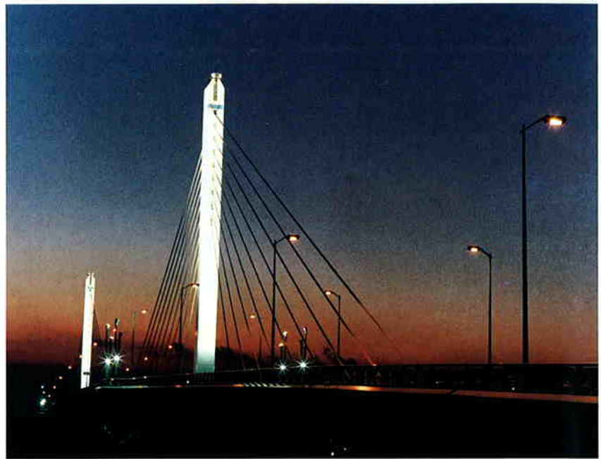
▲ライトアップ：メタルハライドランプ、道路灯：高圧ナトリウムランプ
